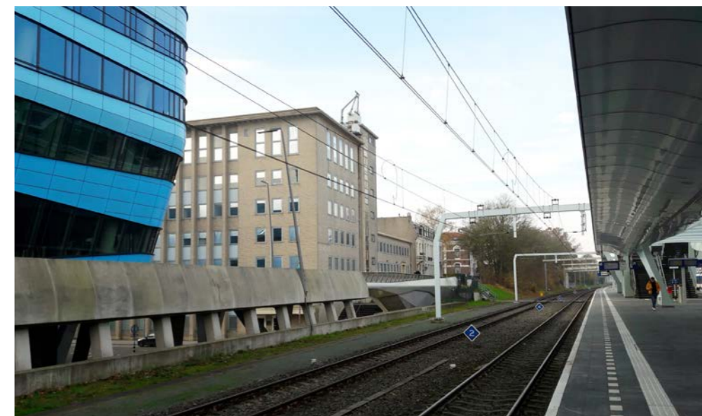
Gebouw gezien vanaf het spoor. Hoek Stationsplein-West - Renssenstraat.
